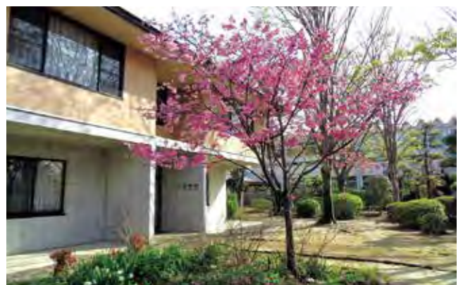
法学部同窓会事務局が入居する 御井学舎内千歳会館
